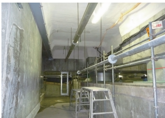
免震ピット RC下地 天井 壁
