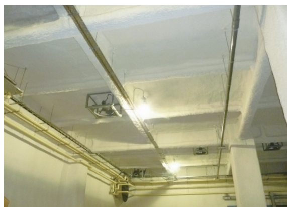
倉庫 RC下地 天井
