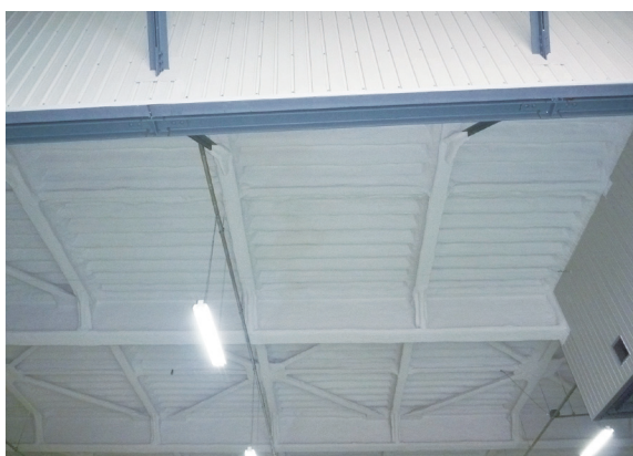
倉庫 デッキ下地 天井
