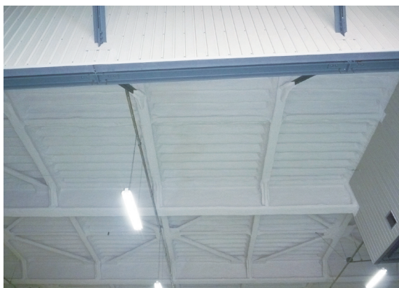
倉庫 デッキ下地 天井
