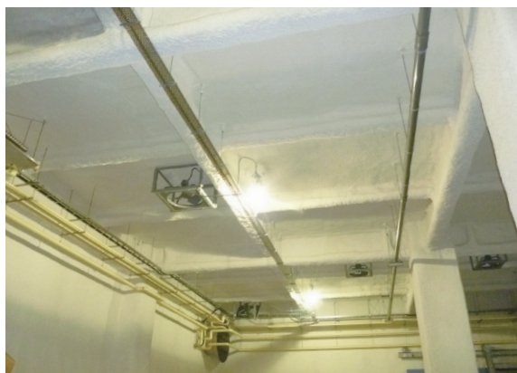
倉庫 RC下地 天井
