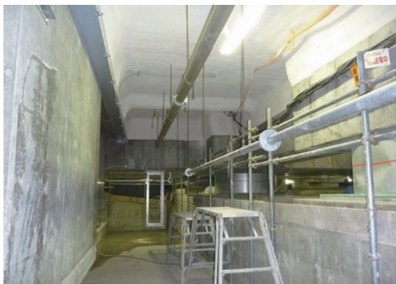
免震ピット RC下地 天井 壁
